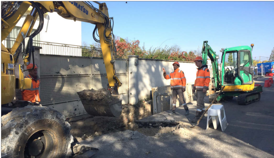
À midi, l'incident était clos. Les travaux sur le réseau d'assainissement ont pu reprendre, rue Basse-Saint-Martin.
